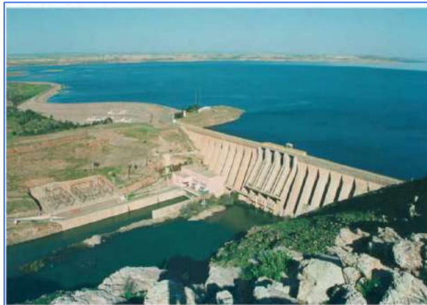
Barrage al Massira
